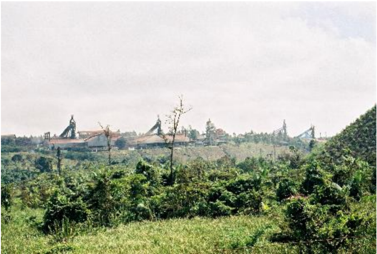
Photo numéro 38 : Les 4 hauts fourneaux et la thermoélectrique (au centre) de la Viena.
