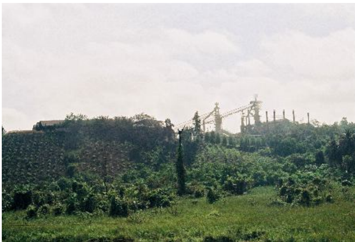
Cliché de l'auteur le 24 mai 2003 vue de la BR 222
