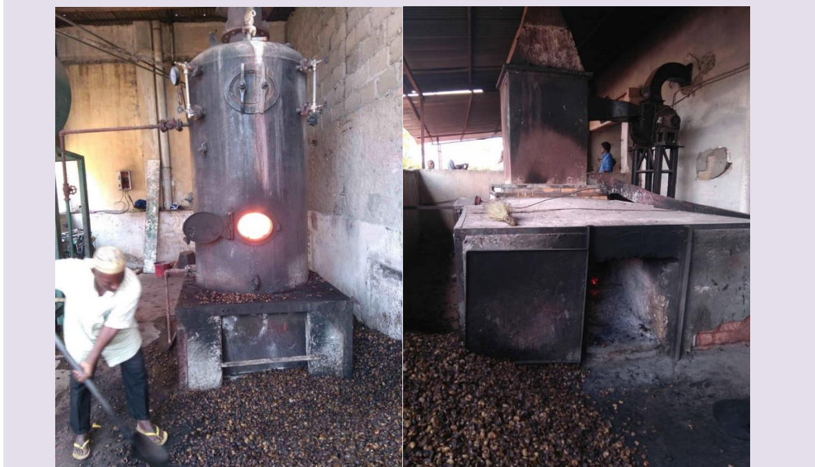
Figura 39. O forno de pirólise pode alimentar caldeiras verticais (na esquerda, Caju Ilha) e secadores (na direita, Mocaju).
