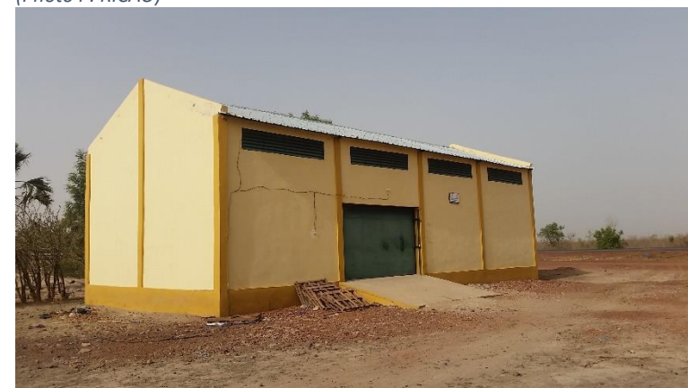
Figure 8: Magasin de stockage de l'Union de Tingoni construit par le P4P (Photo P. RICAU)
