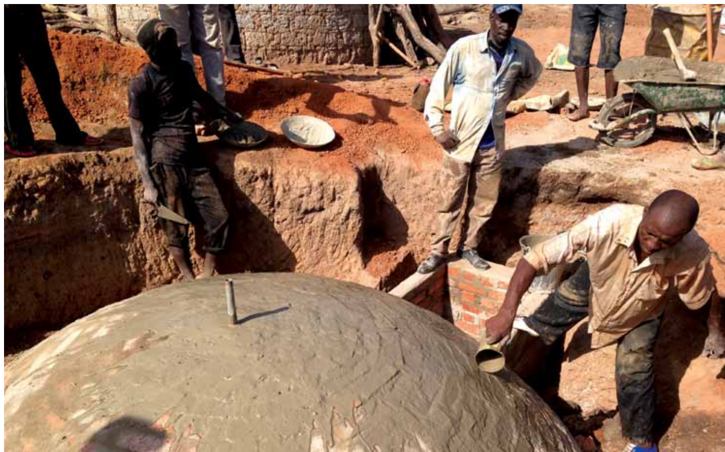
Construction d'un biodigesteur dans le cercle de Bougouni - Mali
