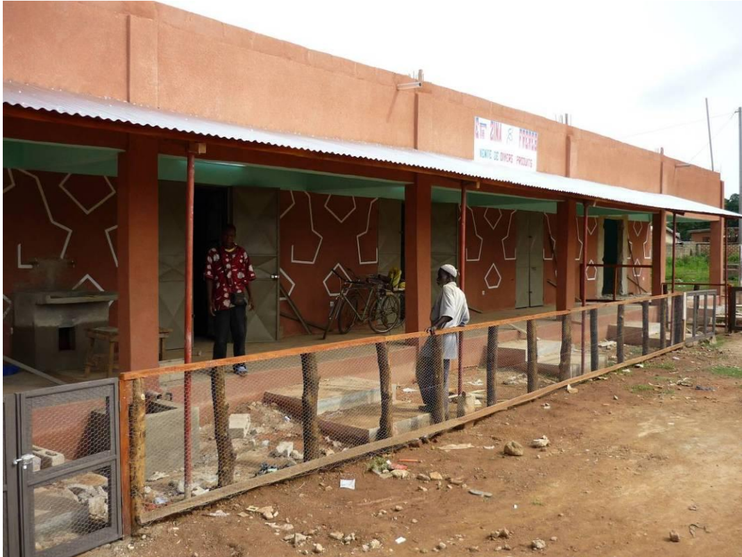
Bâtiment de la plate-forme(source S. Kockmann).
