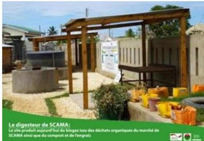
Ce site est le premier biodigesteur qui traite les déchets urbains et valorise entièrement le biogaz généré à Madagascar. Il sert actuellement de lieu de recherche, d'expérimentation, d'échange et de sensibilisation et grâce aux revenus générés par la valorisation du biogaz, il est autonome et rentable.
