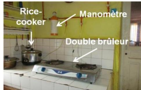
Les connexions biogaz sont réalisées à l'aide de tuyaux rigides en polyéthylène souvent enterrés et fixés au mur.
