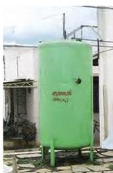
La production de biogaz étant permanente alors que la consommation ne l'est pas forcément, il est souvent nécessaire de le stocker. Le biogaz peut être stocké sur une longue période sans subir de dégradation dans des espaces de stockage rigides ou flexibles qui résistent à la pression et qui sont étanches. La manière la plus simple de stocker le biogaz est un système à basse pression comme un ballon flexible externe au réservoir ou un dôme fixe ou flottant.
