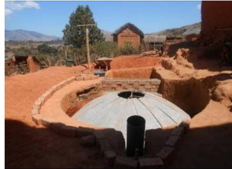
Les matériaux principaux nécessaires à la construction d'un réservoir FAFAFI sont du sable, du gravier et du ciment pour le béton, des briques pour la maçonnerie, d'imperméabilisant et de fer rond.
