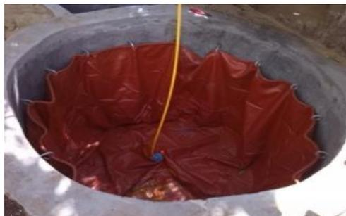
Le biodigesteur ASENSE se construit en 5 jours à l'aide de 2 maçons spécialisés et 3 mains d'œuvre non qualifiées. Sa mise en route s'étale sur 1 à 4 semaines selon les conditions climatiques et la fraîcheur des bouses introduites. Enfin, le dôme en bâche ainsi que les équipements du kit ASENSE obligatoire (tuyaux et raccords, booster pompe pour l'acheminement du biogaz jusqu'aux terminaux, purificateur du biogaz muni d'un
