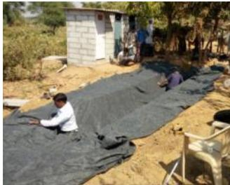
Une fois la tranchée creusée, un géotextile doit y être installé pour protéger le flexible du sol. Le flexible peut alors être déployé dans la tranchée protégée.
