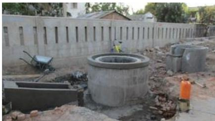
Le projet PASSAT a choisi d'installer un réservoir maçonné de 15 m<sup>3</sup> de type Sino-Indien à cloche flottante plus adapté au traitement des déchets organiques avec une production stable et régulière de biogaz. Le biodigester est composé d'un bac d'alimentation, d'une cuve de fermentation pour la dégradation des matières ainsi qu'un bassin de collecte des effluents. La construction du réservoir a nécessité l'installation d'une base en béton, l'élévation d'un mur en
