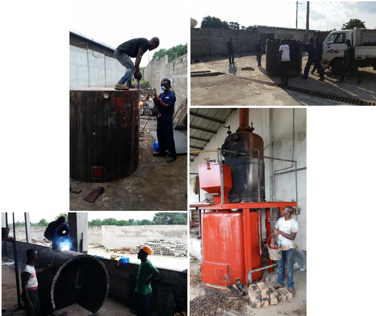
Figure 4 : Travaux de modification du four de Sobery, juillet 2019.
