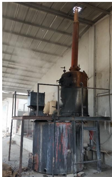
Figure 3 : Four H2CP de Sobery avant les travaux de modification.
