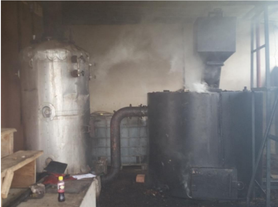
Figure 1 : Installation {four H2CP – chaudière} d’Africa Négoce.
