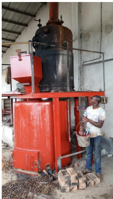
Figure 6 : Four H2CP (à gauche) et chaudière horizontale (à droite) installés à SOBERY
