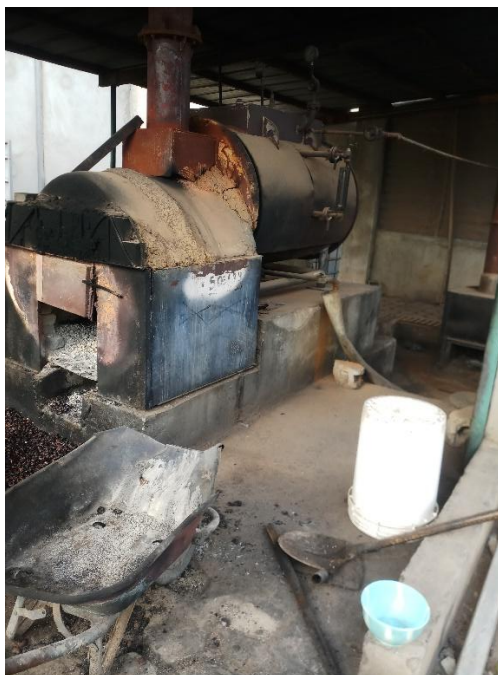
Figure 6 : Four H2CP (à gauche) et chaudière horizontale (à droite) installés à SOBERY
