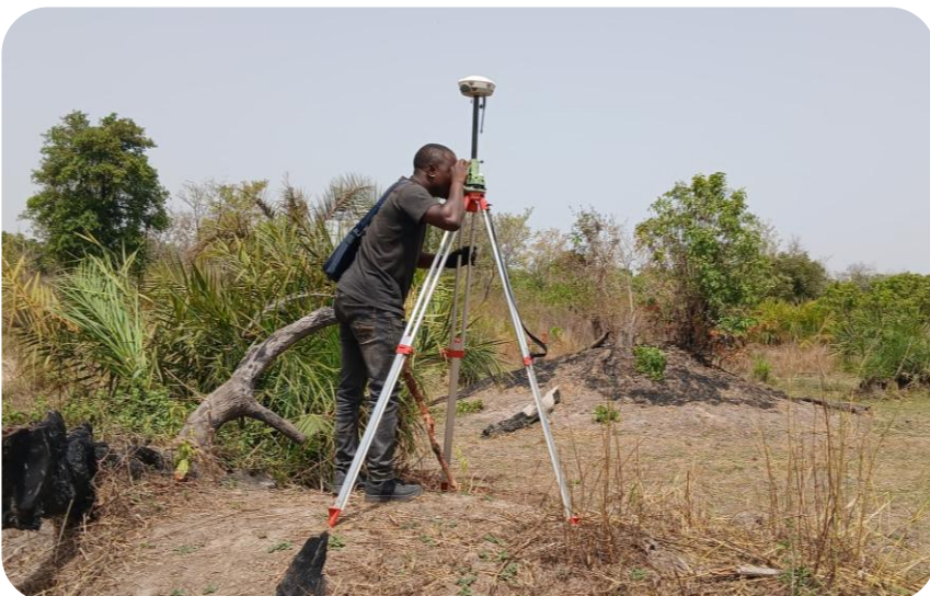
Réalisation des levés topographiques par le cabinet (mars 2025)
