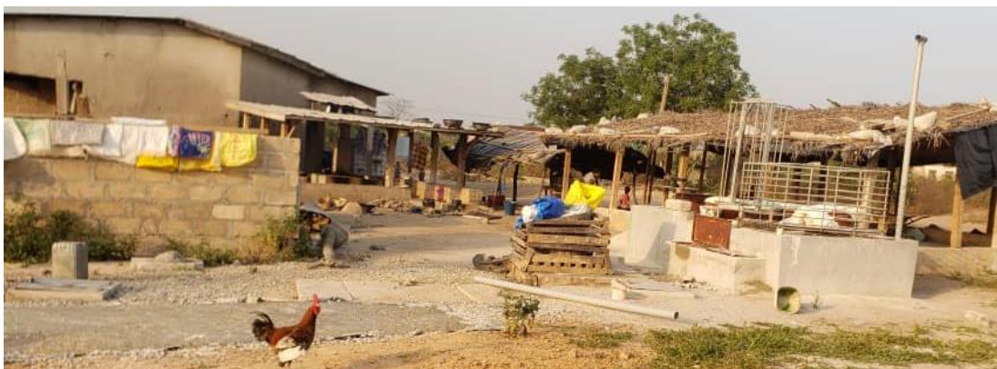
Figure 1: Vue d'ensemble du système (schéma et image). À droite, la plateforme de pressage avec bacs de décantation. À gauche, les fosses Biofile et le regard du puits perdu.
