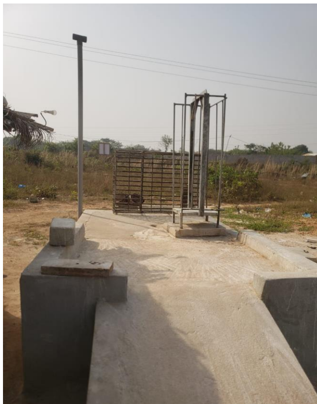
Figure 4: plateforme de pressage avec la cheminée
