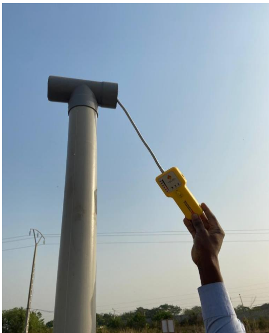
Figure 16: sondage de la cheminée
