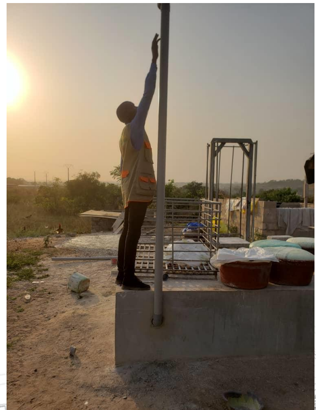
Figure 5: installation de la cheminée
