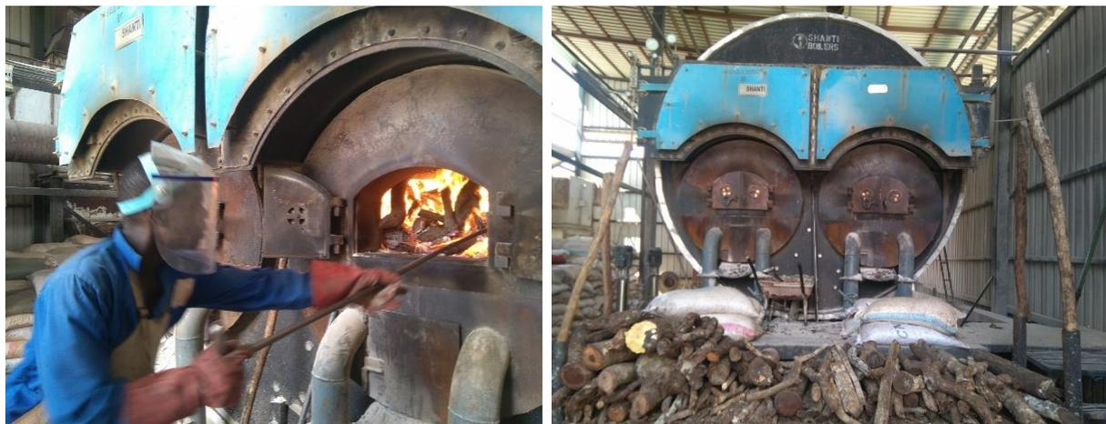
*Figura 21. As caldeiras da fábrica são alimentadas manualmente com lenha de exploração do miombo*
