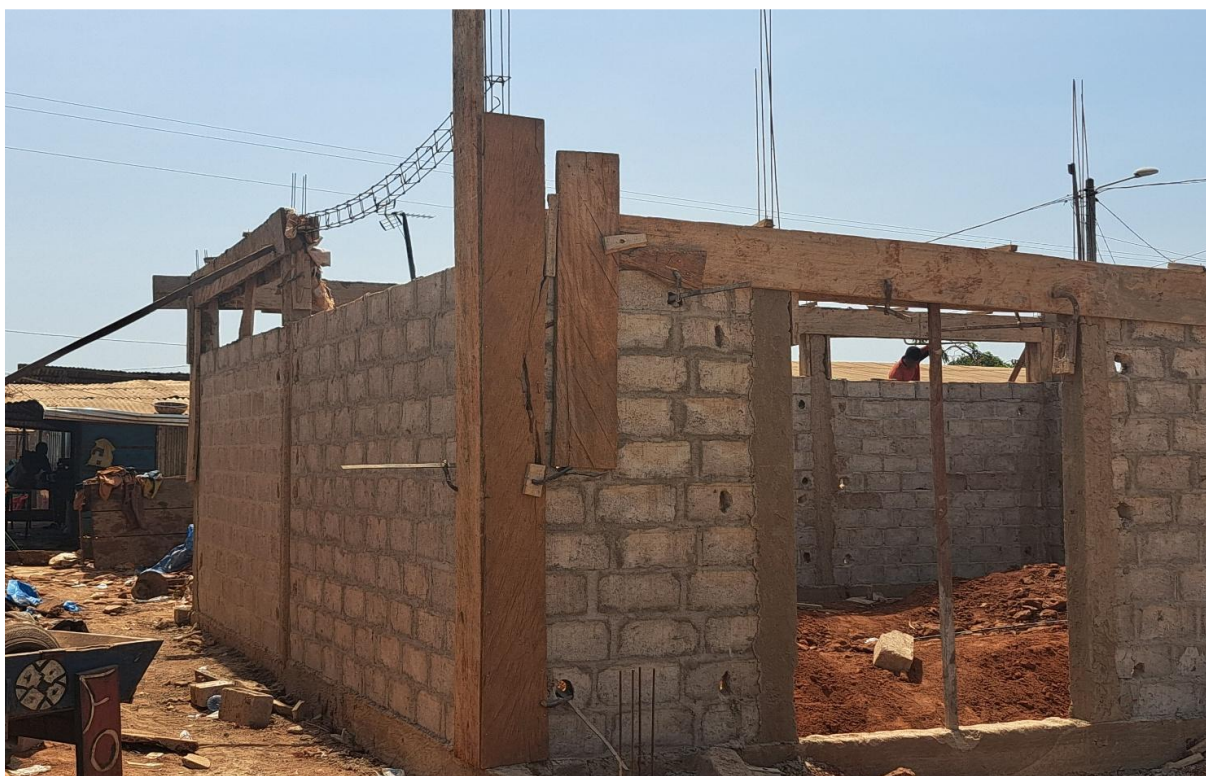
Photo 3. Construction d'un magasin de stockage à Wendènè (novembre 2025)
