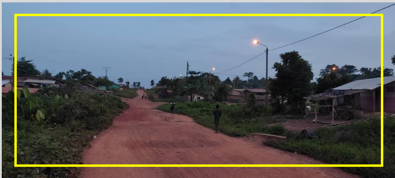
Photo 10 : vue de la rue principale électrifiée à Danguira
