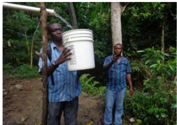
Figure 18 : Mesure de débit avant travaux (gauche) et mesure du débit à l'entrée du bassin de stockage (droite).
