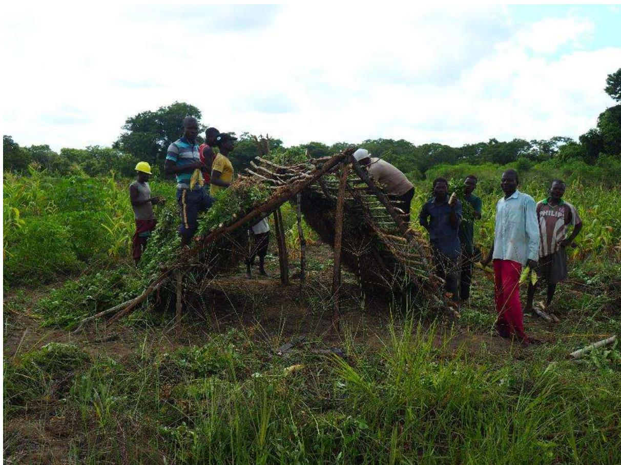
**Figura 14: Capacitação na construção de um secador melhorado realizado com materiais locais (produtores de Musseia)**
