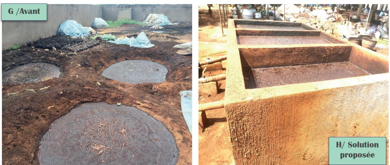
Image 12: (G) fosse d'infiltration et (H) bac de décantation proposé par le projet
