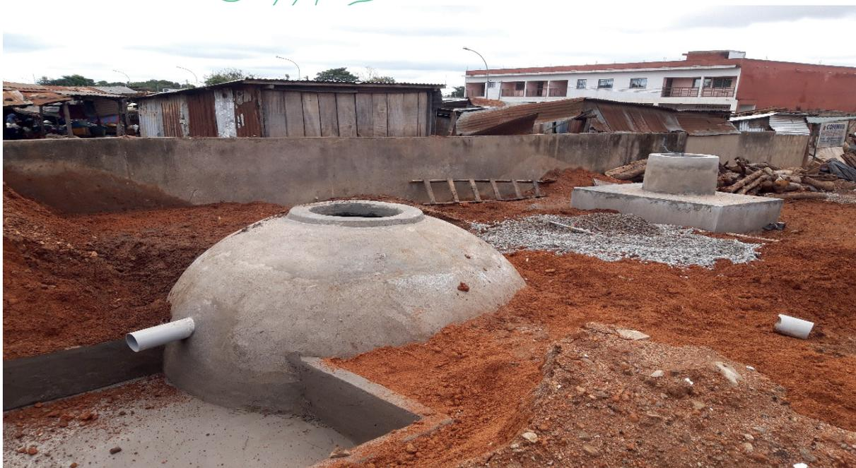
Image 13: biodigesteur en cours de construction. De droit à gauche: bac d'alimentation d'effluents, dôme du biodigesteur (enterré) et bac de récupération du digestat.
